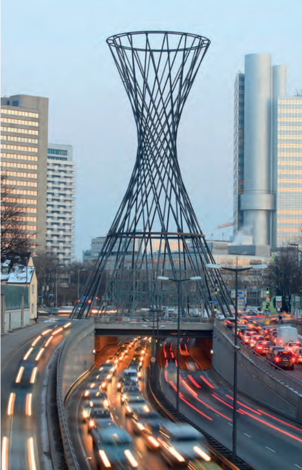
soldan sağa: ■ Biresin® CR84 ile üretilen Münih'deki (Effnerplatz) Mae West heykeli ■ Mae West heykelinde kullanılan 40 m'lik borunun kesiti
